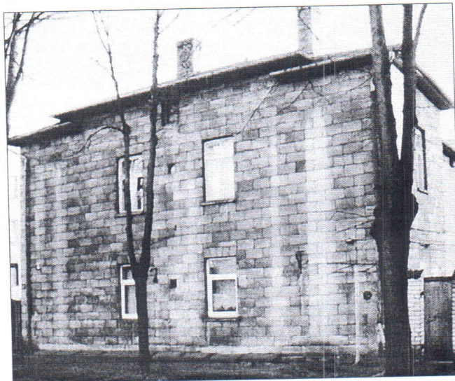
Рис. 1. Дом из мелких газобетонных блоков без штукатурки (возраст 70 лет)
