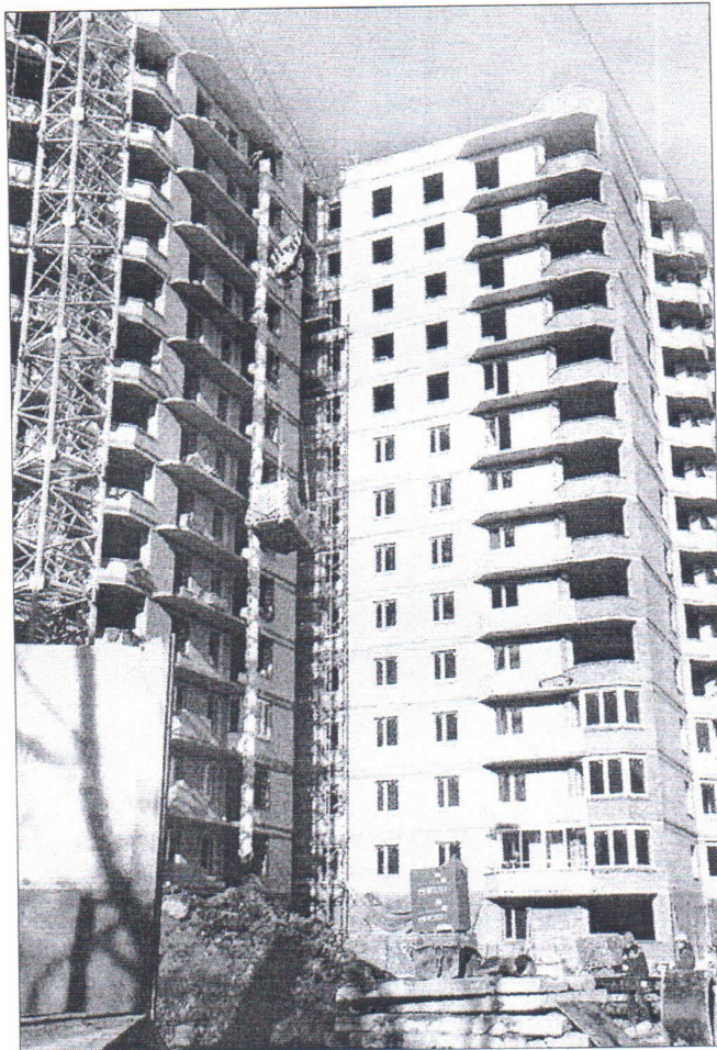
Рис. 8. Многоэтажные дома из газосиликатных блоков, строящиеся в Санкт-Петербурге
