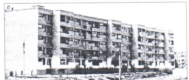
Рис. 5. Цельногазобетонные дома серии 126: а – в крупноблочном исполнении (гг. Тверь и Ржев); б – в мелкоблочном варианте (г. Астрахань)
