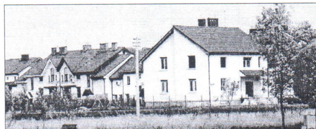
Рис. 11. Сельское газобетонное строительство в Беларуси
